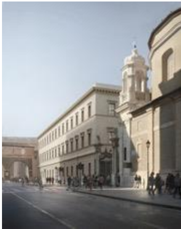
Fig. 1 : La façade donnant sur l'Italie sera maintenue.
