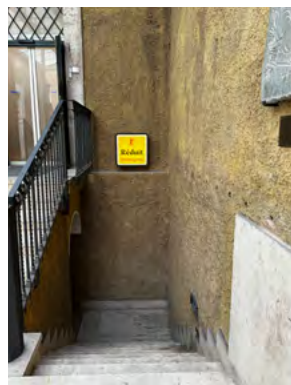
Entrée du réduit
