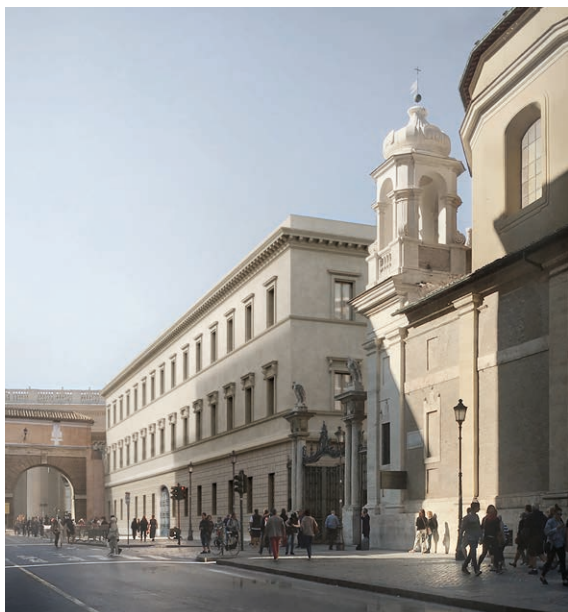
Fig. 1 Conservation de la façade vers l'Italie.
