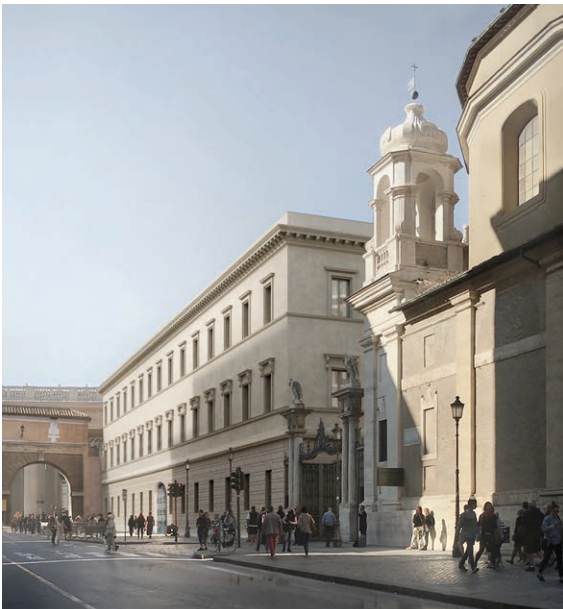
Abb. 1: Erhalt der Italien zugewandten Fassade
